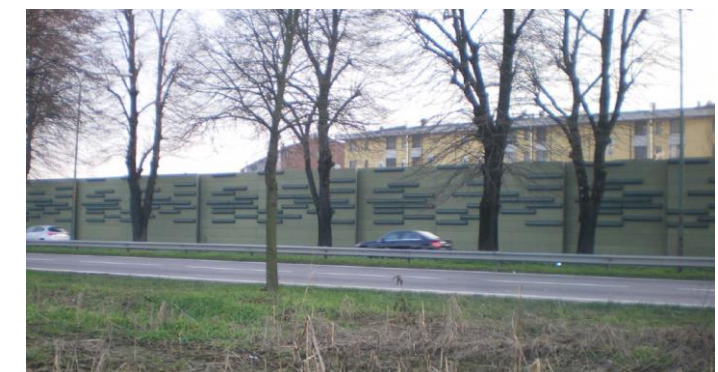
Installazione a Cremona, in tangenziale
