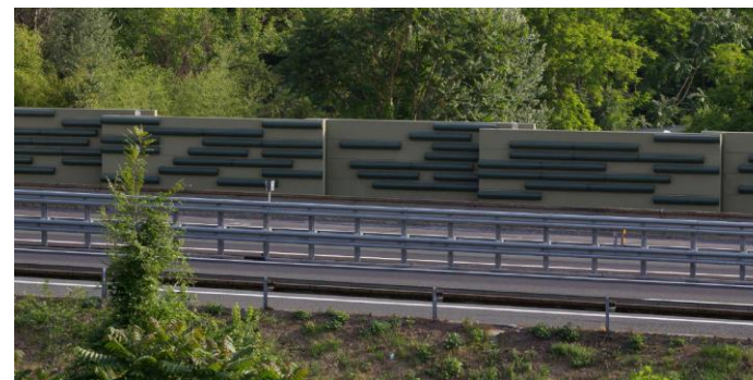
Installazione in autostrada a Seravezza (LU)
