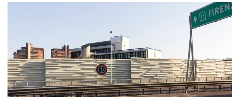
Installazione su autostrada a Casalecchio di Reno
